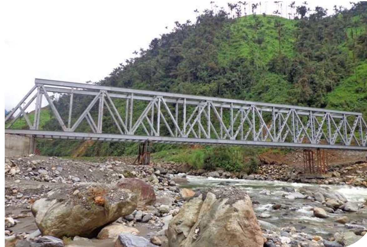
● RÍO UPANO Bridge.
