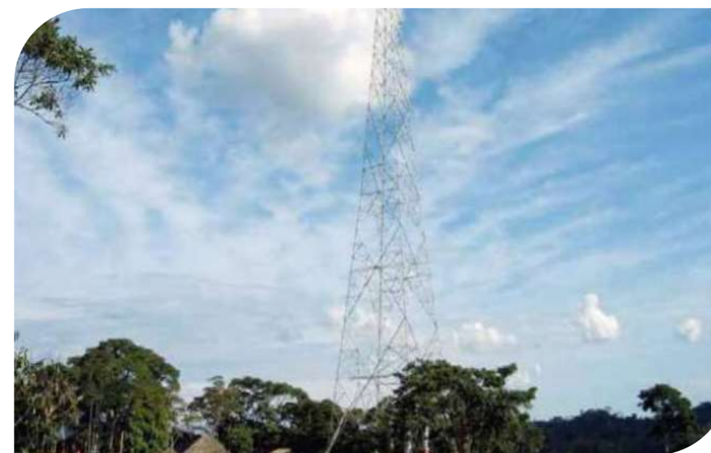
● Cruce del Río Napo 69kV Transmission Line.
