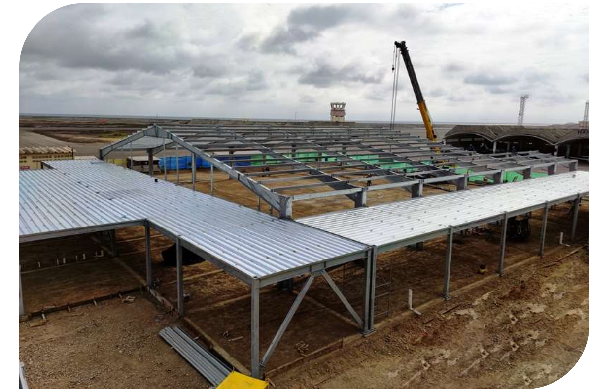
● Construcción Galpón de Aeronaves FAE SALINAS.
