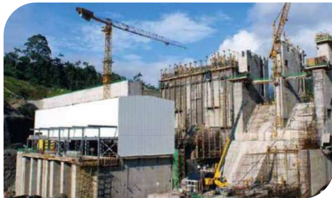
● Central Hidroeléctrica Manduriacu
