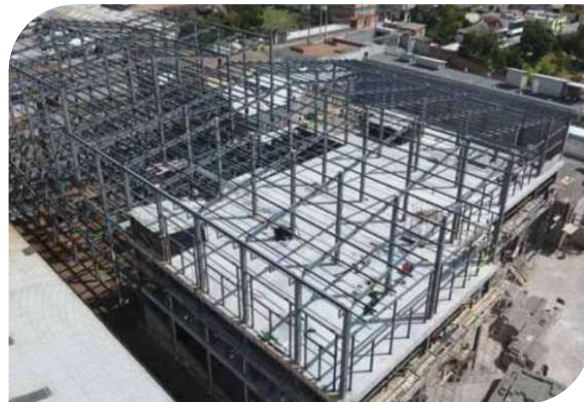
● Construcción de la Planta de Producción Nilotex
