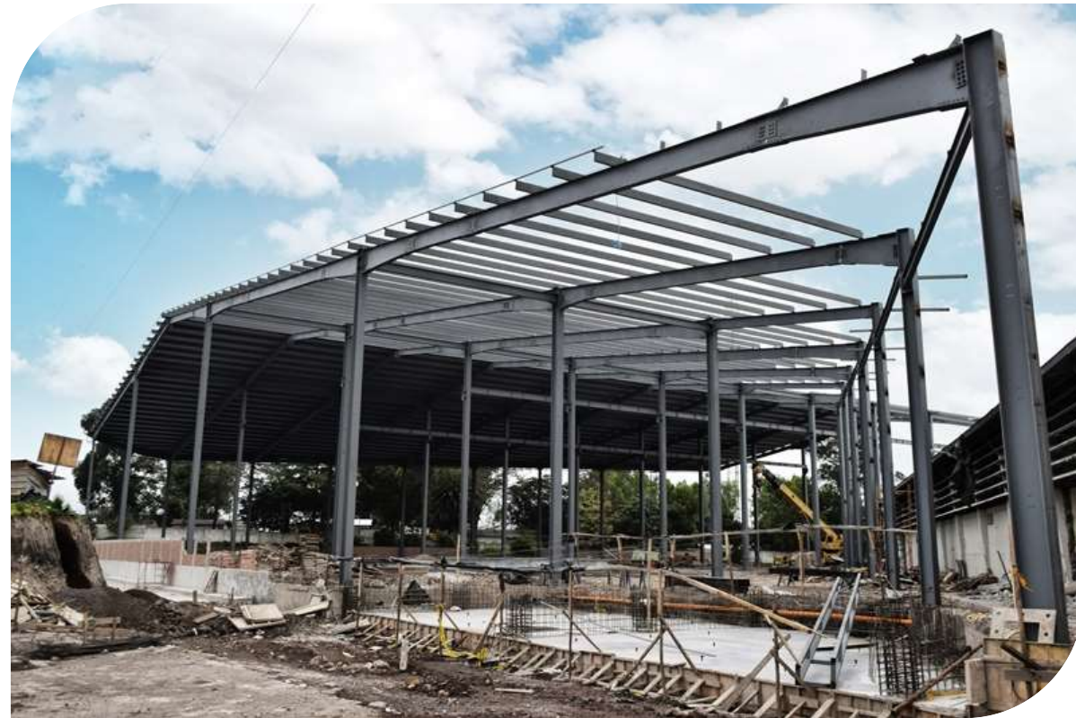
● Construcción de la Planta Industrial CHAIDE & CHAIDE
