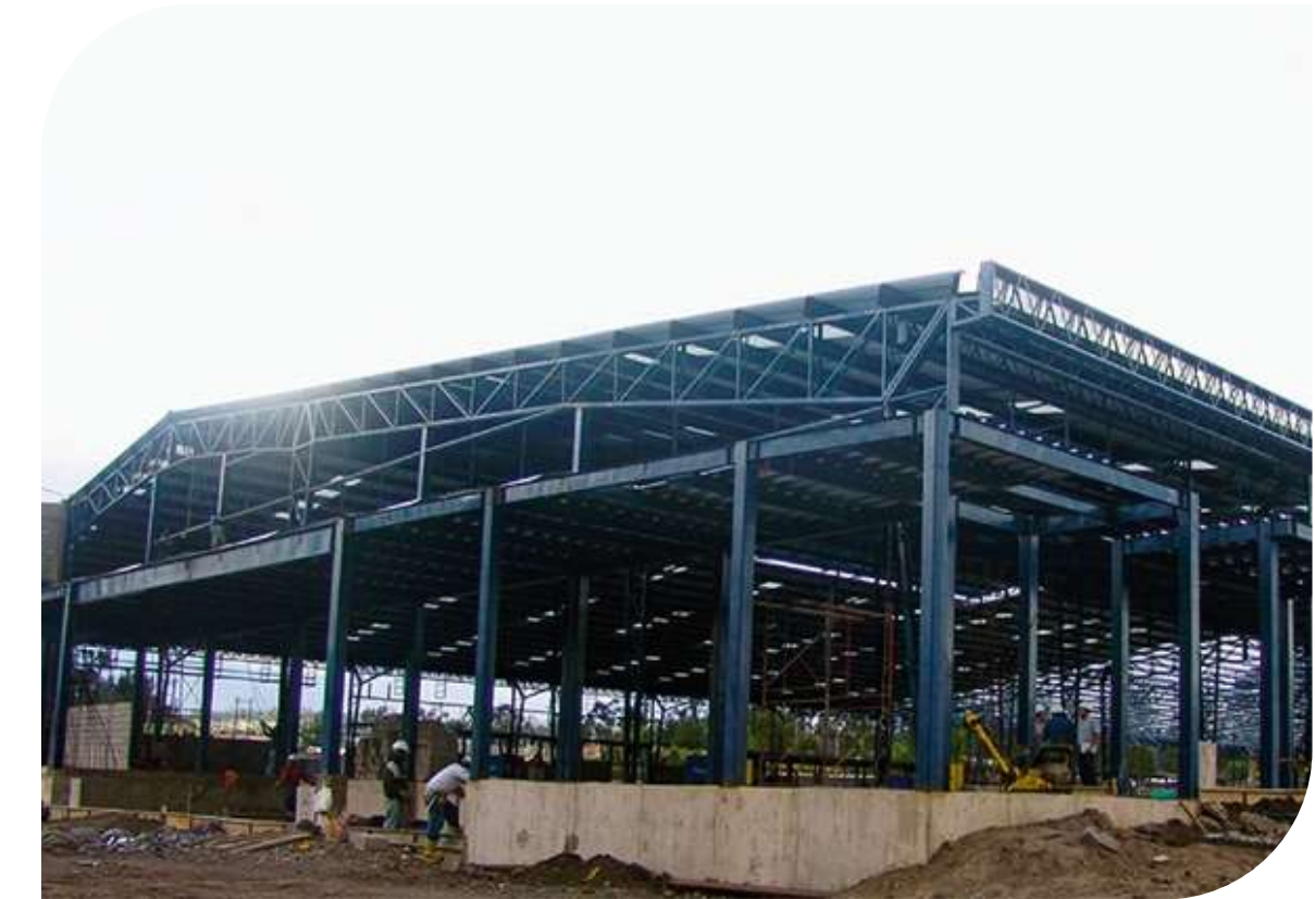
● Construcción de la Planta Industrial GENERAL MOTORS
