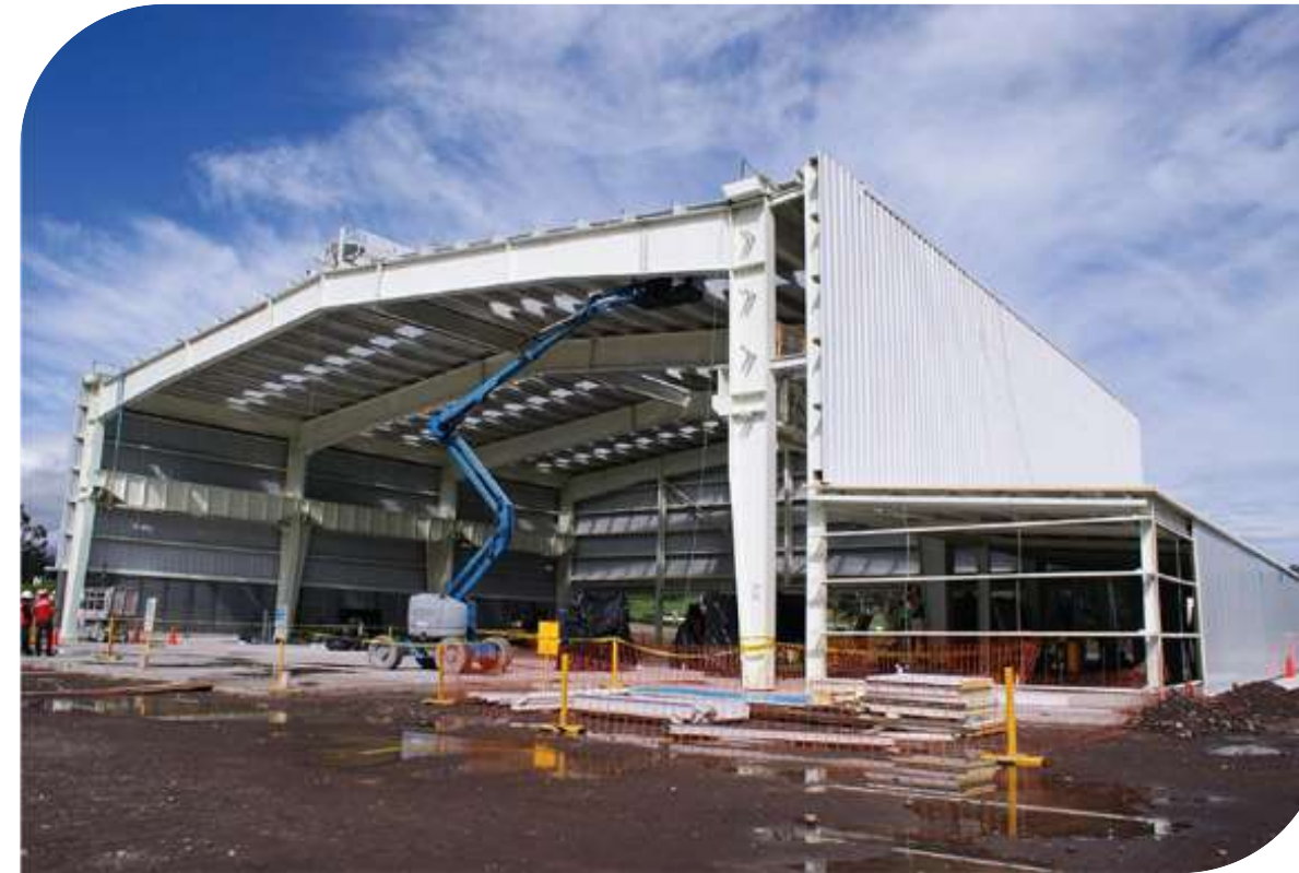
● Construcción de la Planta Industrial TENARIS
