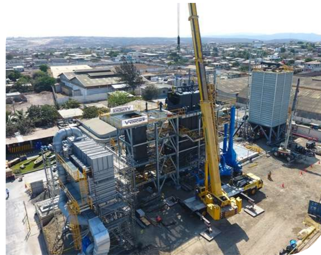
● Construcción Planta de Biomasa LA FABRIL
