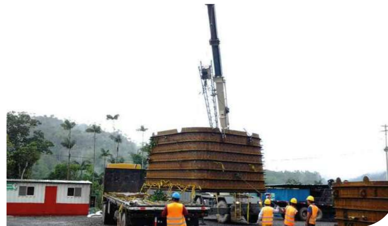
● Central Hidroeléctrica Manduriacu Transición y Blindaje de Desagüe
