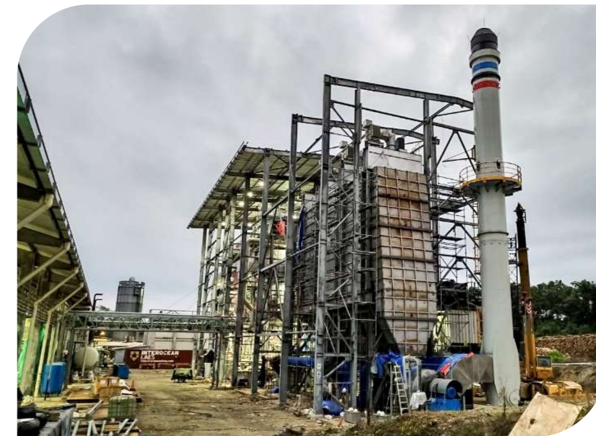
● Construcción Planta de Biomasa BOTROSA
