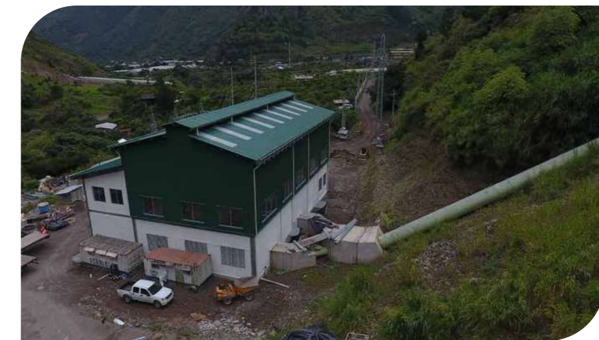
● Central Hidroeléctrica Hidrosierra Casa de Máquinas y Tubería
