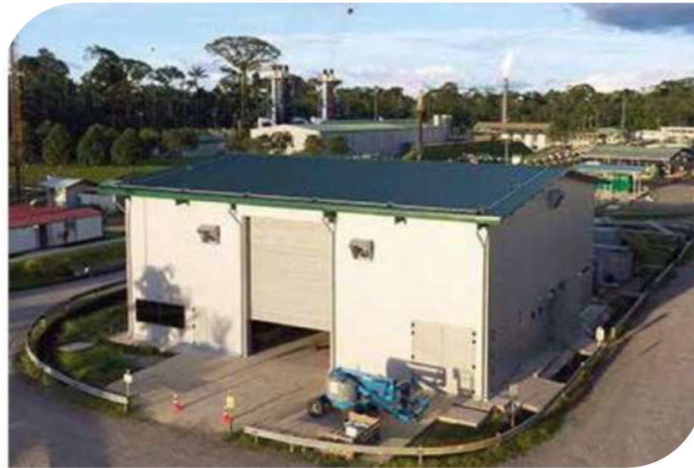
● Taller de Mantenimiento Bloque 12 - PAM
