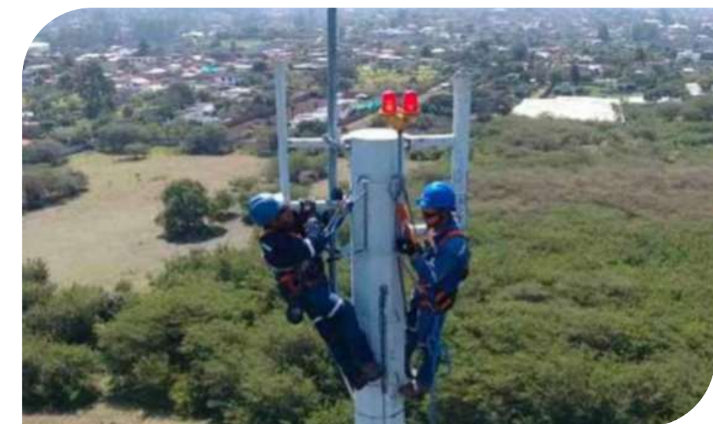
● Mantenimiento de Torres y Monopulos
