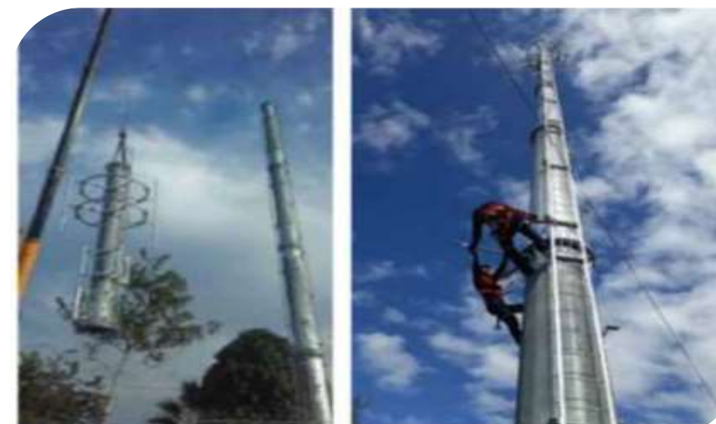
● Suministro de estructura para Torreros 2017 - 2018
