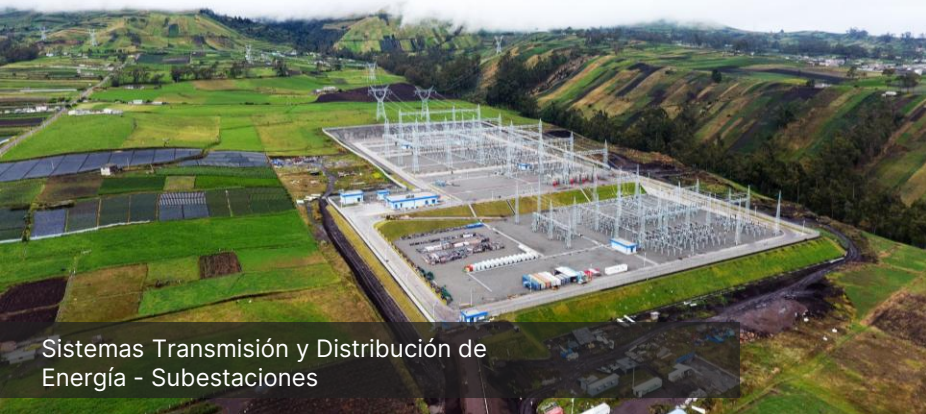
Sistema Nacional Interconectado 500Kv.
